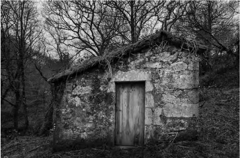
O muíño de Xenlle do Medio é moito máis baixo que o anterior e a canteiría non é tan fina. Este foi arraxado en tempos recentes e botóuselle unha placa de formigón no teito, co que se poderá conservar durante bastantes máis anos.
