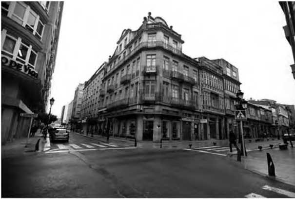
Edificio A esquina. Foto Bernabé.
