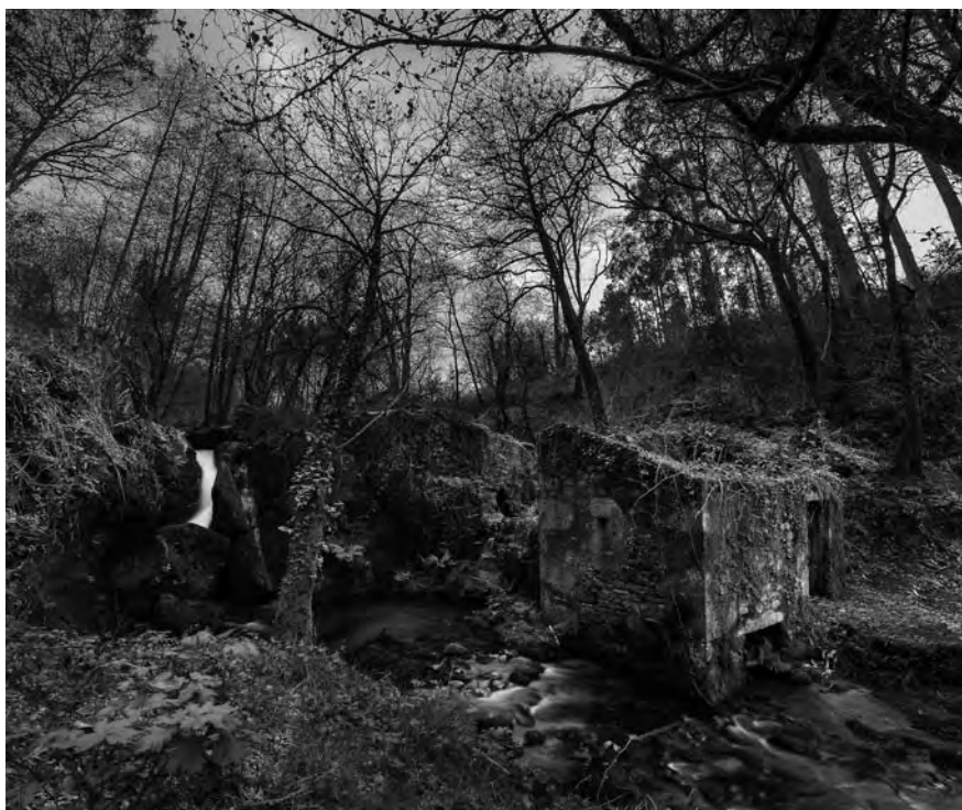
Vista xeral da ferverza da Firga e do complexo de muíños do mesmo nome (os muíños da Firga) que collen as augas uns metros por riba da súa caída: lugar propicio para instalalos dado o brusco desnivel, o que conleva ademais unha levada do máis curta.
